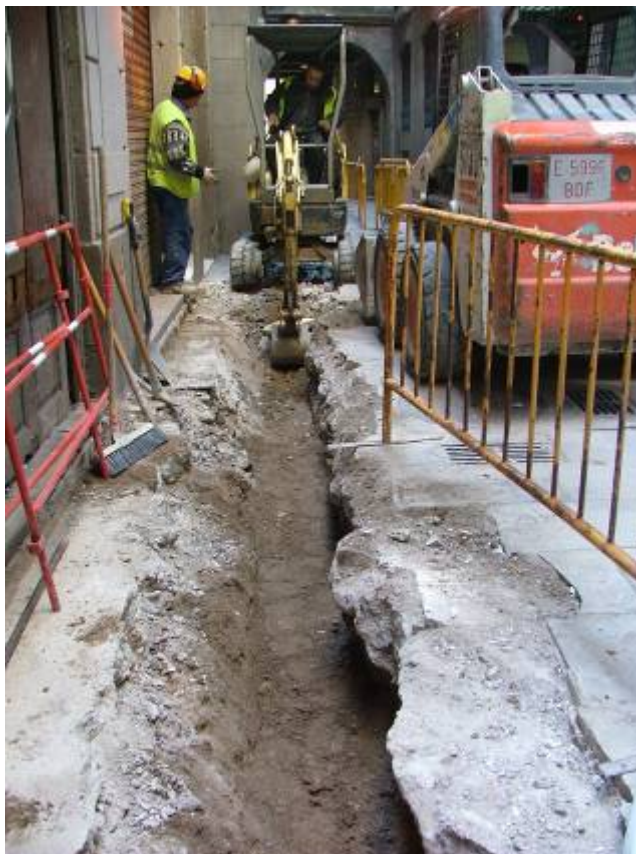
Foto 3: Treballs constructius al carrer de Grunyí
