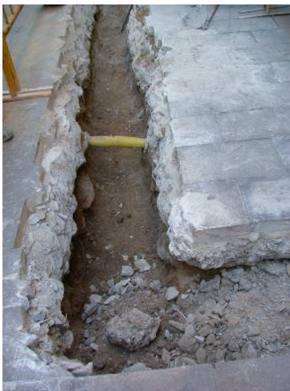
Foto 4: Imatge de detall de la profunditat de la rasa en la cantonada del carrer Grunyí-Mirallers.
